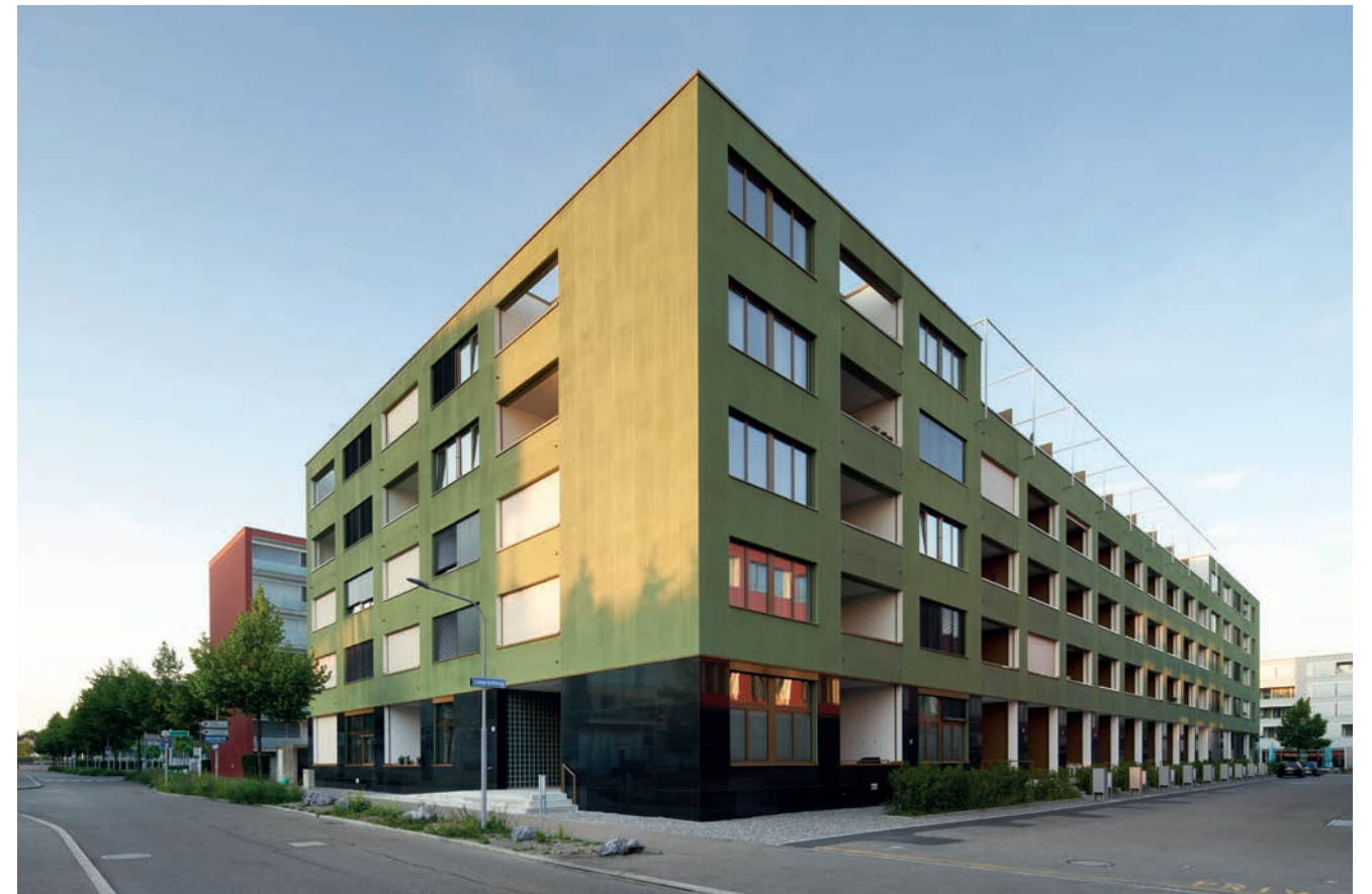
Durch die komplementäre Farbgebung der Fassade hebt sich das Gebäude von seinen beiden benachbarten Geschwisterbauten ab. Als Loggien ausgebildete private Aussenräume erhalten das Fassadenbild aufrecht und erlaubten baurechtlich die Aufstockung des Attikageschosses.
