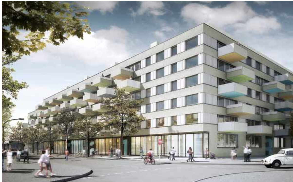
Mit der Typologie des Blockrands wird auf die unterschiedlichen Nachbarräume reagiert. Die Fensterbänder mit dem Vorhangeffekt ziehen sich rund um das Gebäude.
